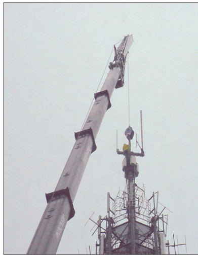
Bild 3: Antenneninstallation mit Kran
